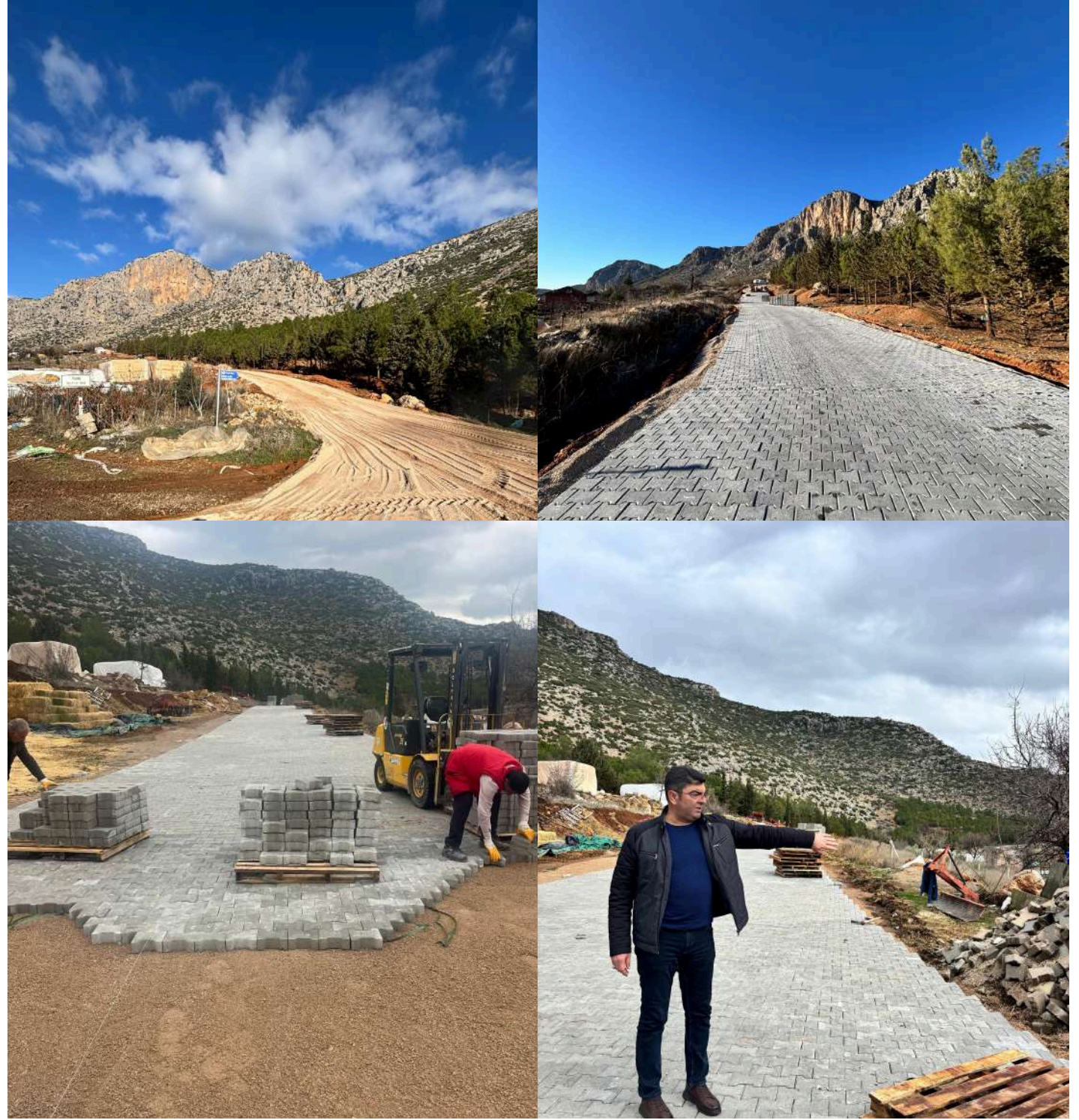
Beldemiz Yuva Mahallesi Kilit Parke Yol Çalışmaları
