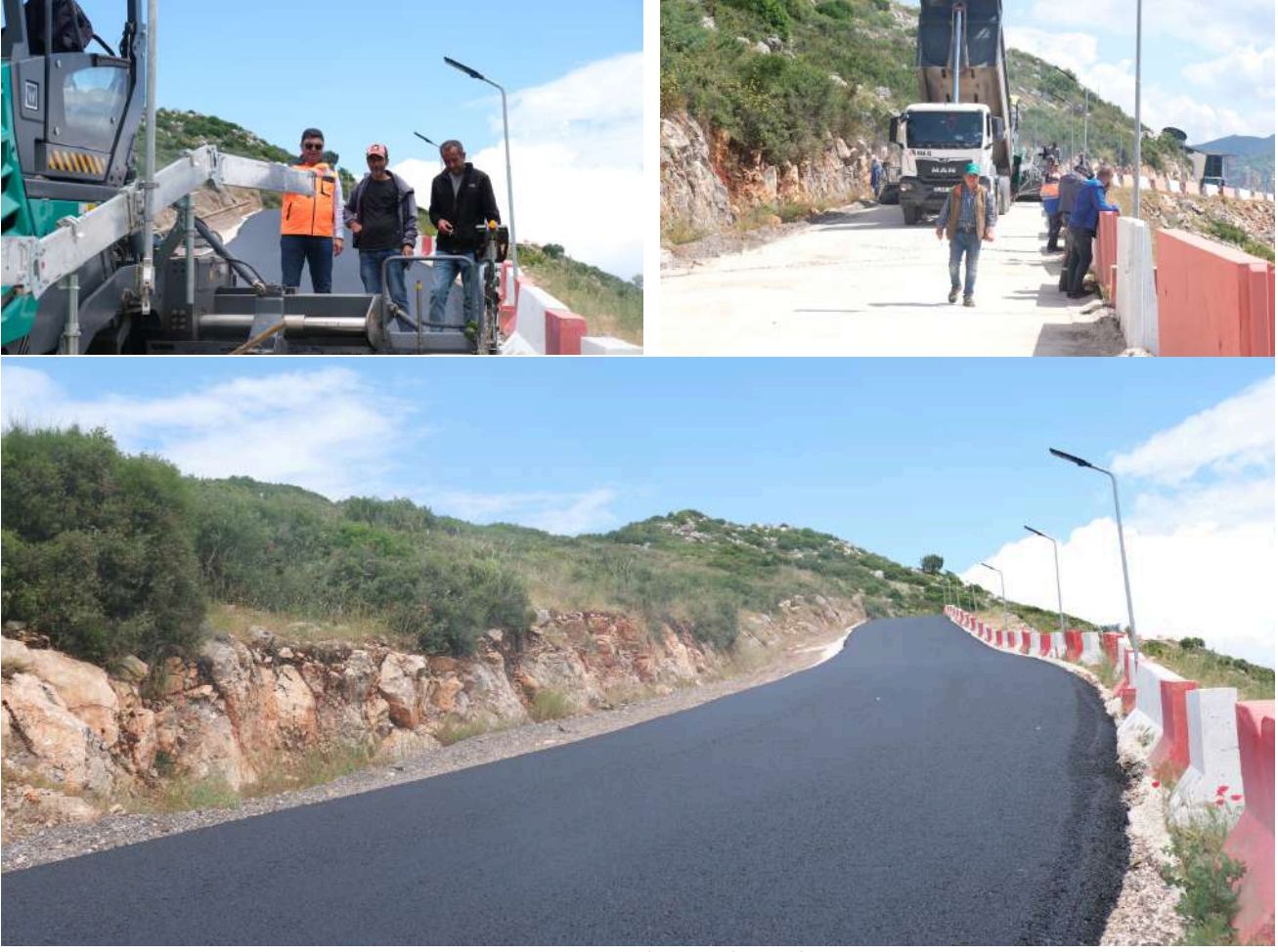
Seyir Terası Yol Asfalt Çalışması
